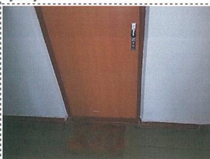
Vstupné dvere do bytu č. 909
