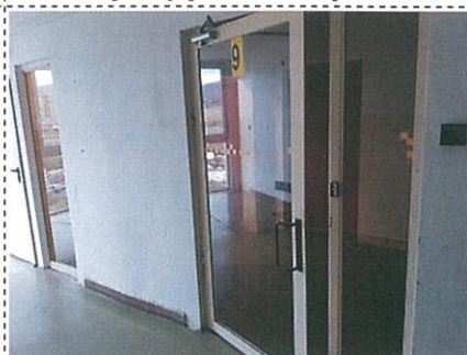
Chodba na 9. NP k výťahom
