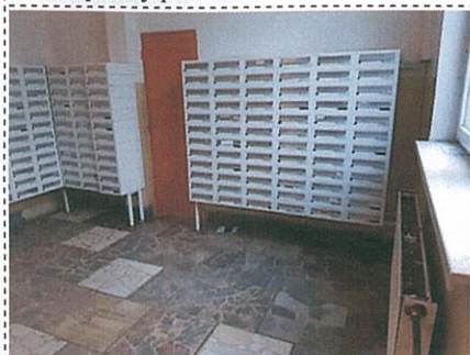
Zádverie vstupu do byt. domu
